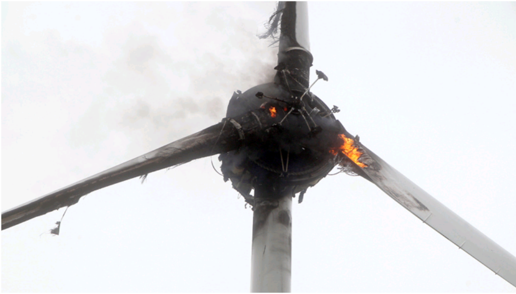
Brand i vindkraftverk
